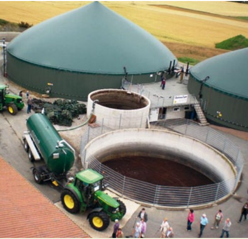
Blick auf die Biogasanlage JSJ Peckelsheim / Foto: Stephanie Fix
